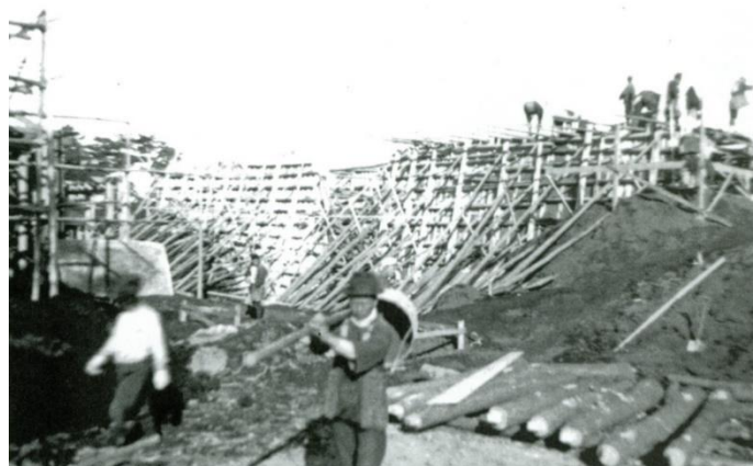
資料 3 線路の盛り土工事 (国立駅付近)
