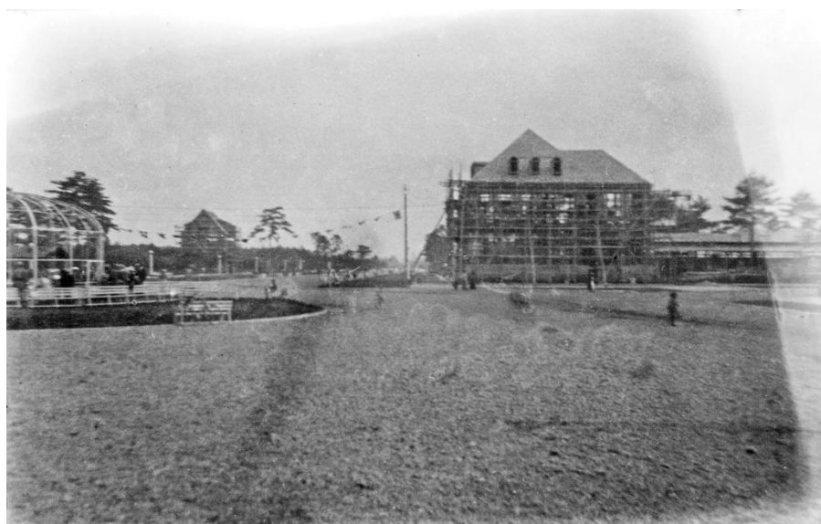
資料 7 建築中の箱根土地本社 大正 15 (1926) 年 明窓浄机館所蔵 (中島陟資料)
