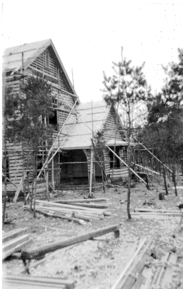
資料 3 建築中の堤邸 大正 15 (1926) 年 明窓浄机館所蔵 (中島陟資料)
