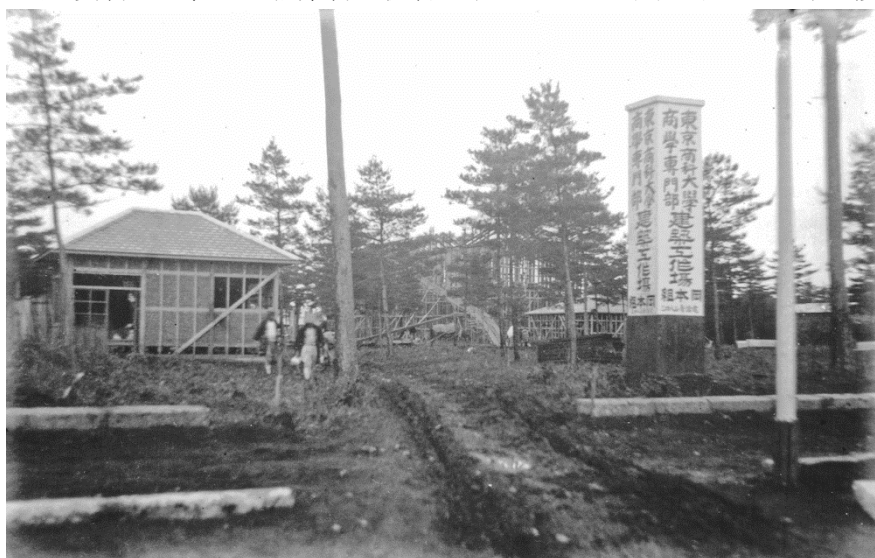
資料 4 東京商科大学商学専門部建築工場 大正 15（1926）年 明窓浄机館所蔵（中島陟資料）
