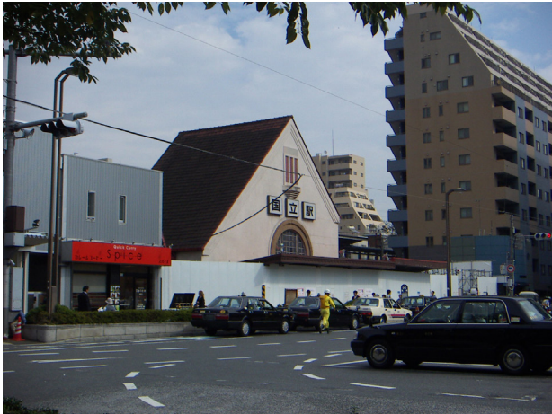
写真4 解体前の国立駅舎 2006（平成18）年10月11日撮影
