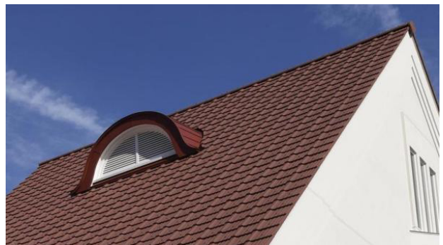
参考写真 再築された旧国立駅舎 画像提供(3点とも): 国立市
