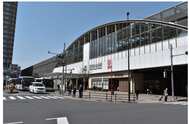
現在の武蔵小金井駅南口 令和 6（2024）年 3 月撮影
