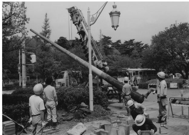
写真25 大学通りの電柱撤去
